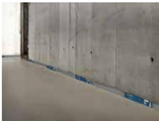
**Thermische Trennung der Wände direkt im Bauteil**
